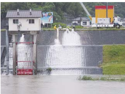
古津賀地区排水作業状況
