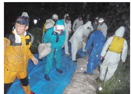
水防団による積み土のう工
