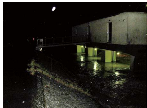
有岡樋門(水位上昇)
