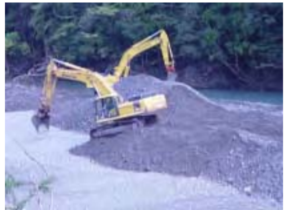
長安口ダム上流での掘削による土砂の除去
