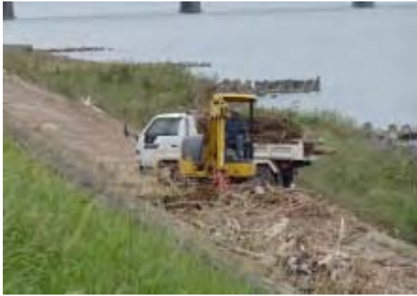
洪水時に漂着した流木等の処理（塵芥処理）
