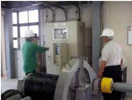
水門の点検状況
