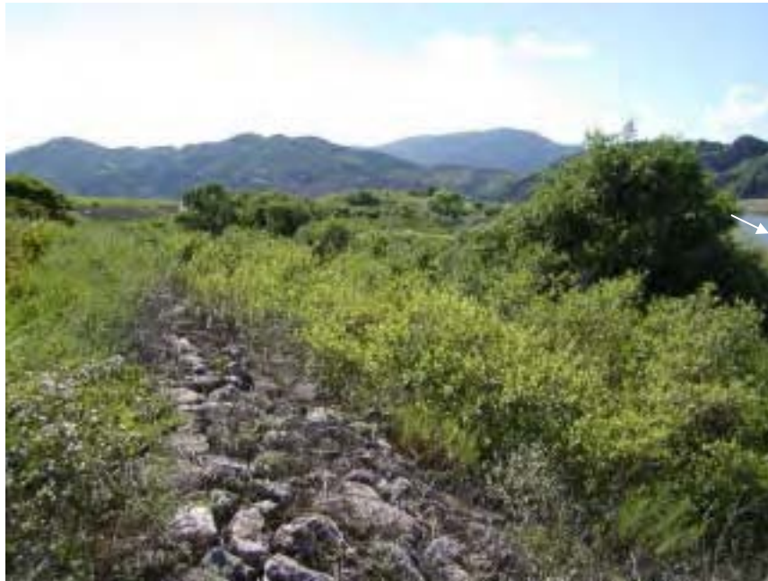
那賀川多自然型低水護岸（9.2km付近）
