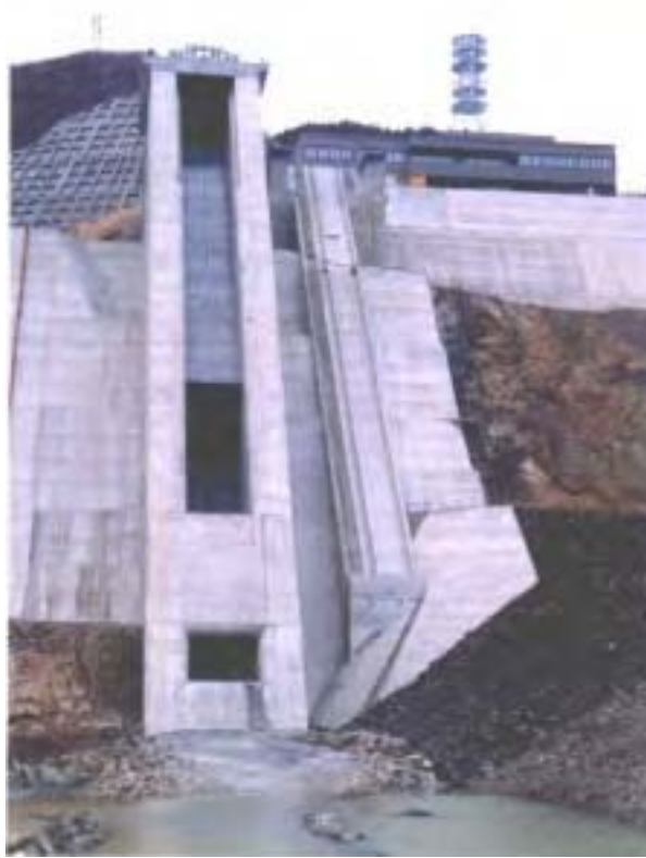
選択取水設備の設置（東北地方整備局：七ヶ宿 しちかしゆく ダムの事例）
