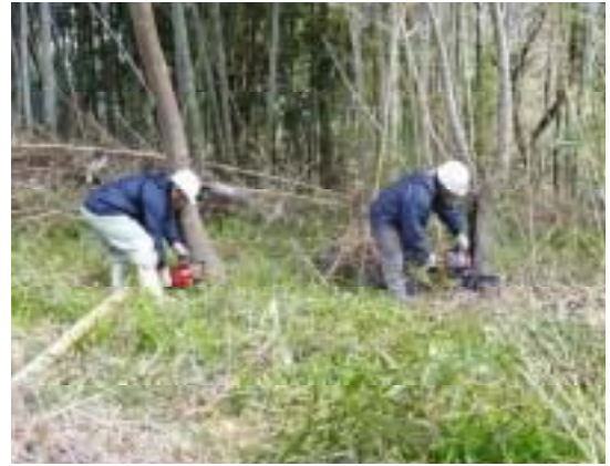
河道内の樹木伐採
