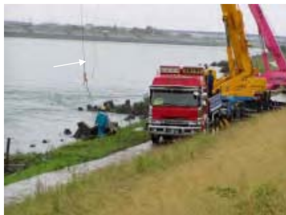
被災箇所の応急復旧
