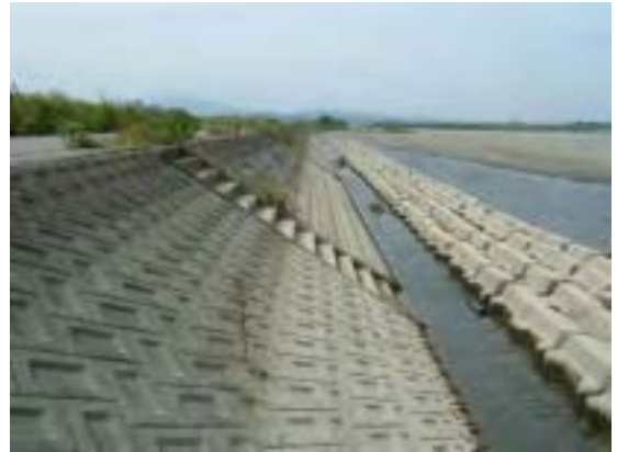
連続した根固ブロック
