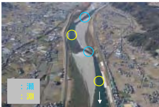
瀬・淵の連続性（北岸堰下流）
