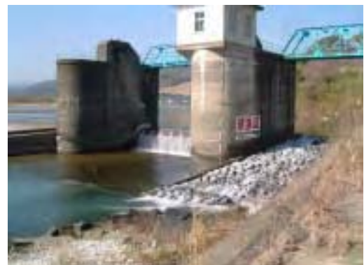
北岸堰の魚道の状況
