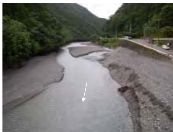
長安口ダム上流の堆砂状況（坂州木頭川）
