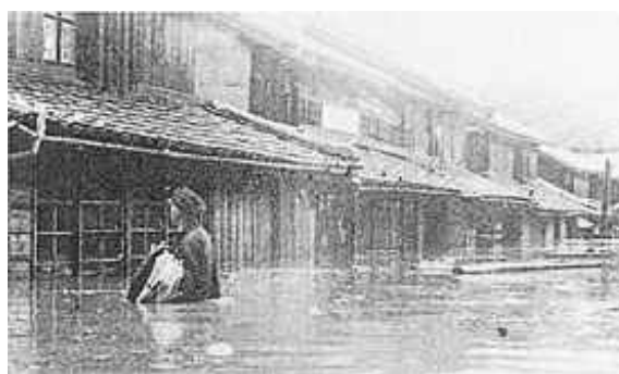
那賀町（旧鷲敷町）和食地区の浸水状況 （昭和25年9月）
