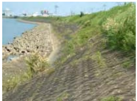
連続した根固ブロック
