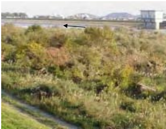
河道内の樹木繁茂（平成16年）
