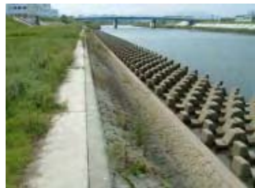
連続した根固ブロック
