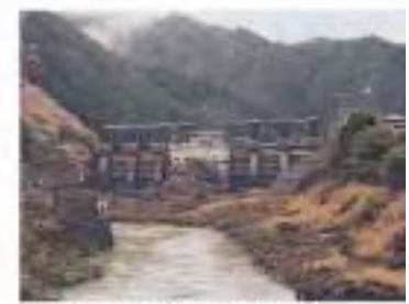
川口ダム (徳島県) 川口発電所 ・位置/那賀町古野
