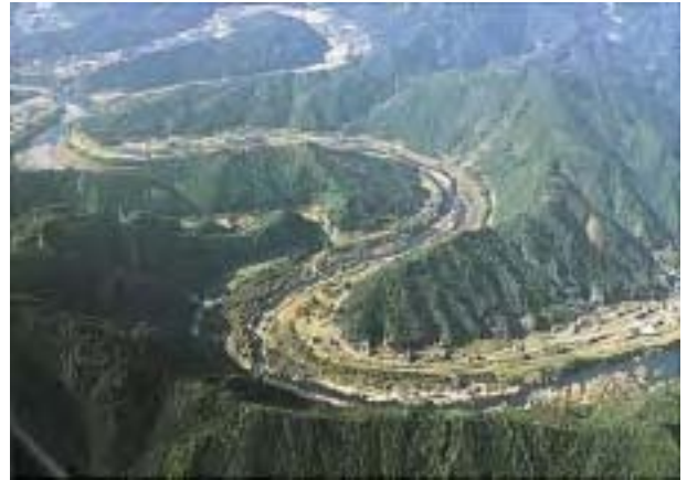
驚敷ライン（那賀川中流域）
