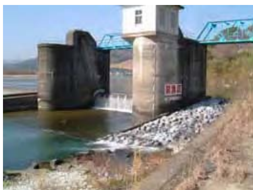
北岸堰の魚道の状況
