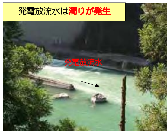
発電所（日野谷）放流〔H18.8.7撮影〕
