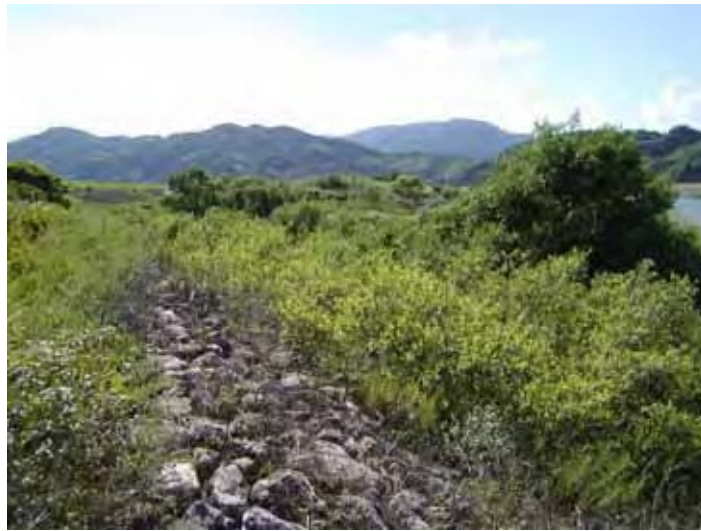
那賀川多自然型低水護岸（9.2km 付近）
