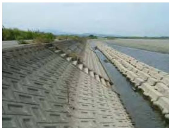
連続した根固ブロック
