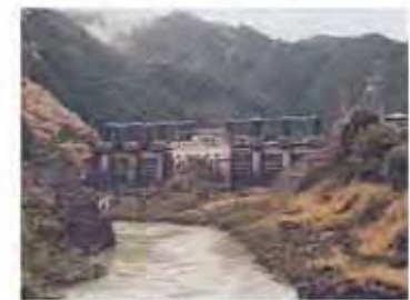
川口ダム (徳島県) 川口発電所 ・那賀町吉野 ・位置/那賀町吉野
