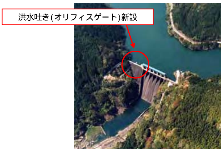
図 5.1.3 洪水吐き（オリフィスゲート）新設
