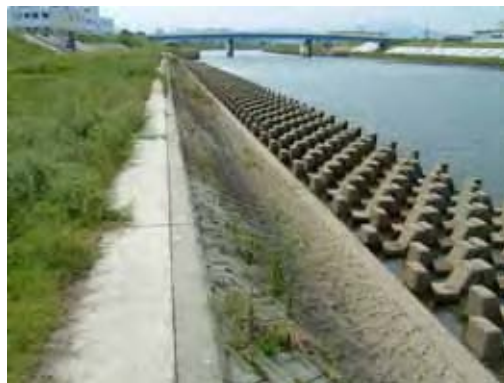
連続した根固ブロック
