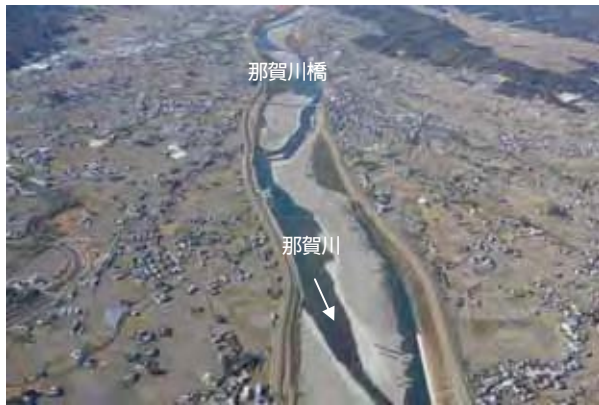
那賀川橋付近
