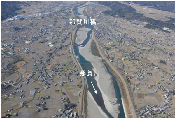
那賀川橋付近
