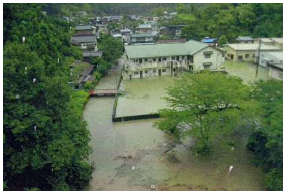
那賀町平谷地区の浸水状況
