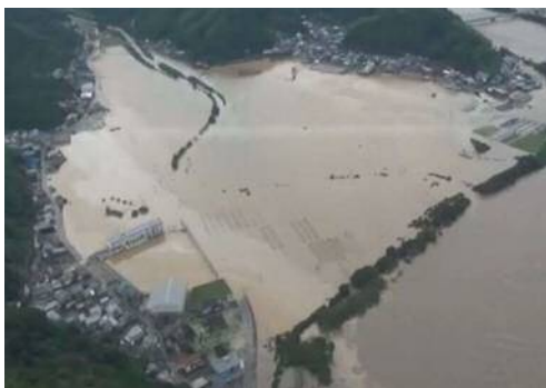
阿南市加茂町加茂地区の浸水状況
