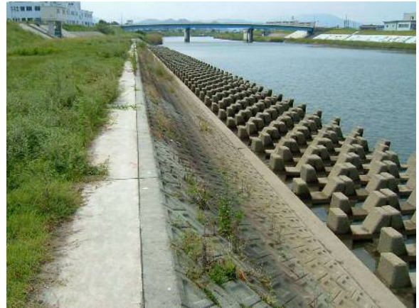
連続した根固ブロック
