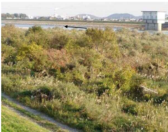
河道内の樹木繁茂（平成16年）
