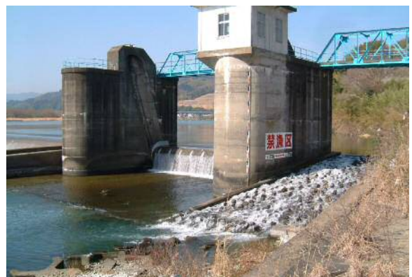
北岸堰の魚道の状況
