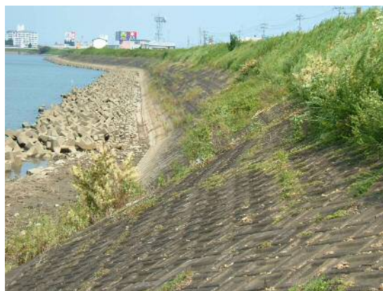
連続した根固ブロック
