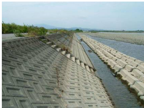
連続した根固ブロック
