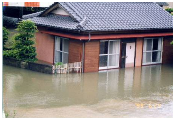
阿南市宝田町川原地区の浸水状況
