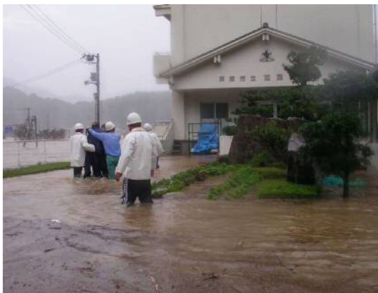
阿南市加茂町加茂地区の浸水状況
