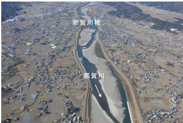
那賀川橋付近
