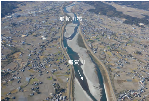
那賀川橋付近
