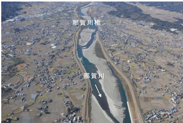
那賀川橋付近
