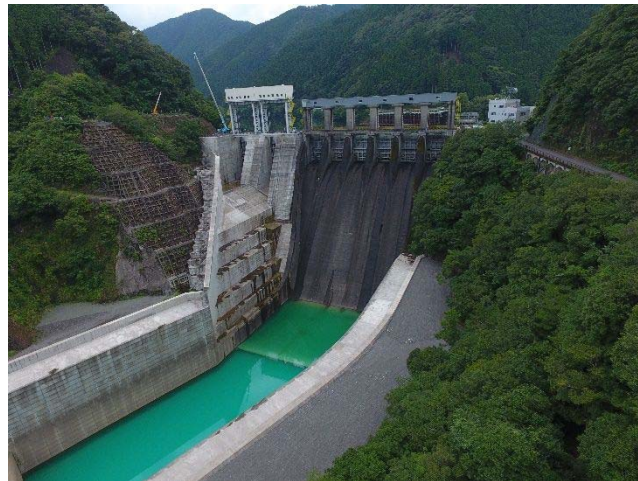
長安口ダム(令和3年7月)
