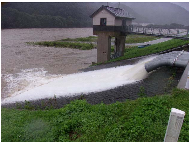
【深瀬地区】令和元年8月15日、15時44分
