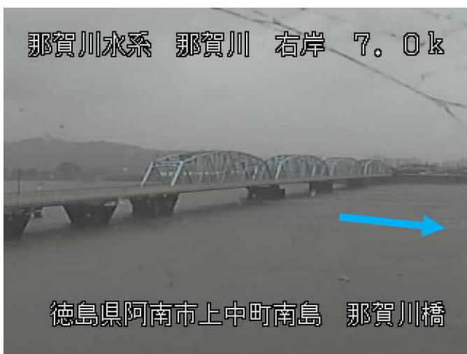
▲ 那賀川橋（那賀川河口から7km付近） 令和元年8月15日15時10分頃 水位5.89m（古庄地点）
