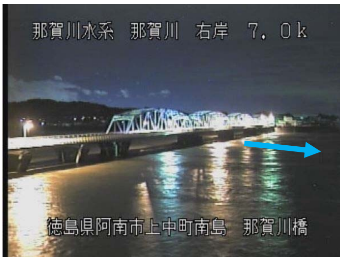
▲ 那賀川橋（那賀川河口から7km付近） 平成30年9月30日22時00分頃 水位5.77m（古庄地点）
