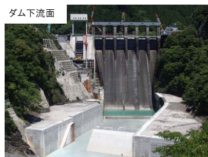
11BL堤体切削完了
