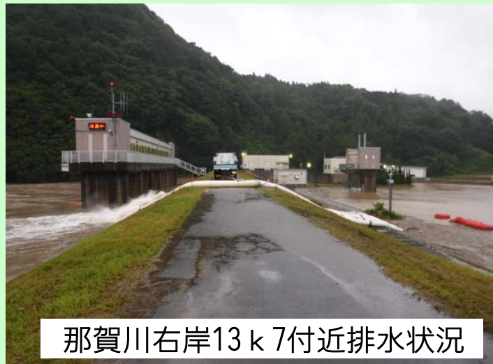
那賀川右岸13k7付近排水状況
