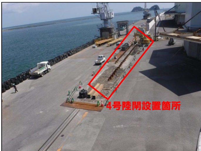
現地施工前状況
