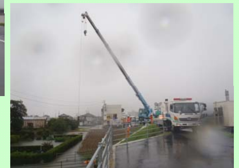
桑野川左岸3k 6付近排水状況
