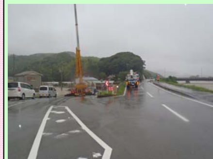
桑野川右岸3k 2-79付近排水状況
