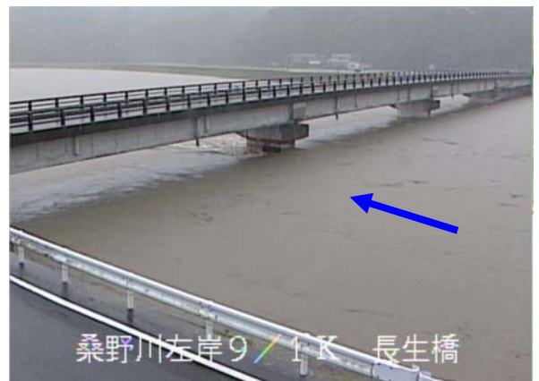
ながいげばし くわのがわ ▲ 長生橋（桑野川河口から9 km付近） （平成26年8月2日15時10分頃） 水位5.54mの時の大原地点 平常時の水位から約4m上昇
