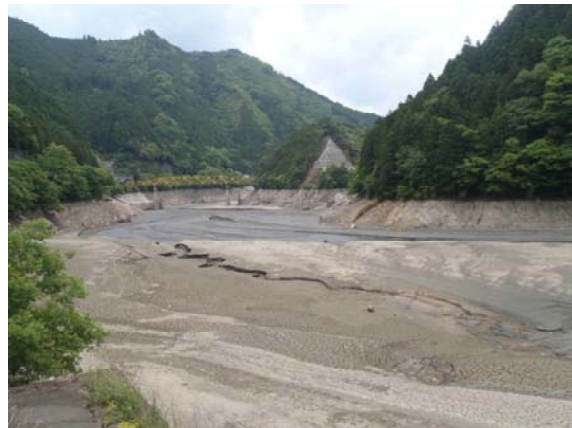
出合橋より上流付近
