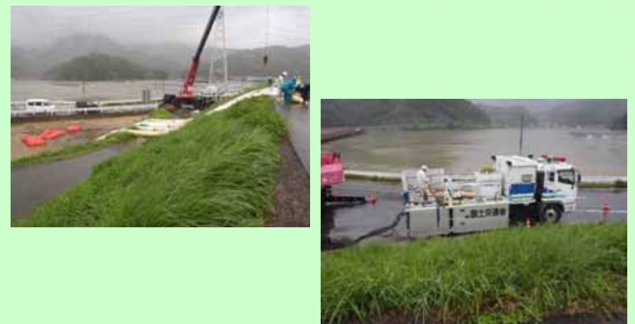
排水ポンプ車排水状況(那賀川右岸13.8km付近)
