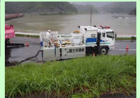
▲排水ポンプ車排水状況(那賀川右岸18.8km付近)
