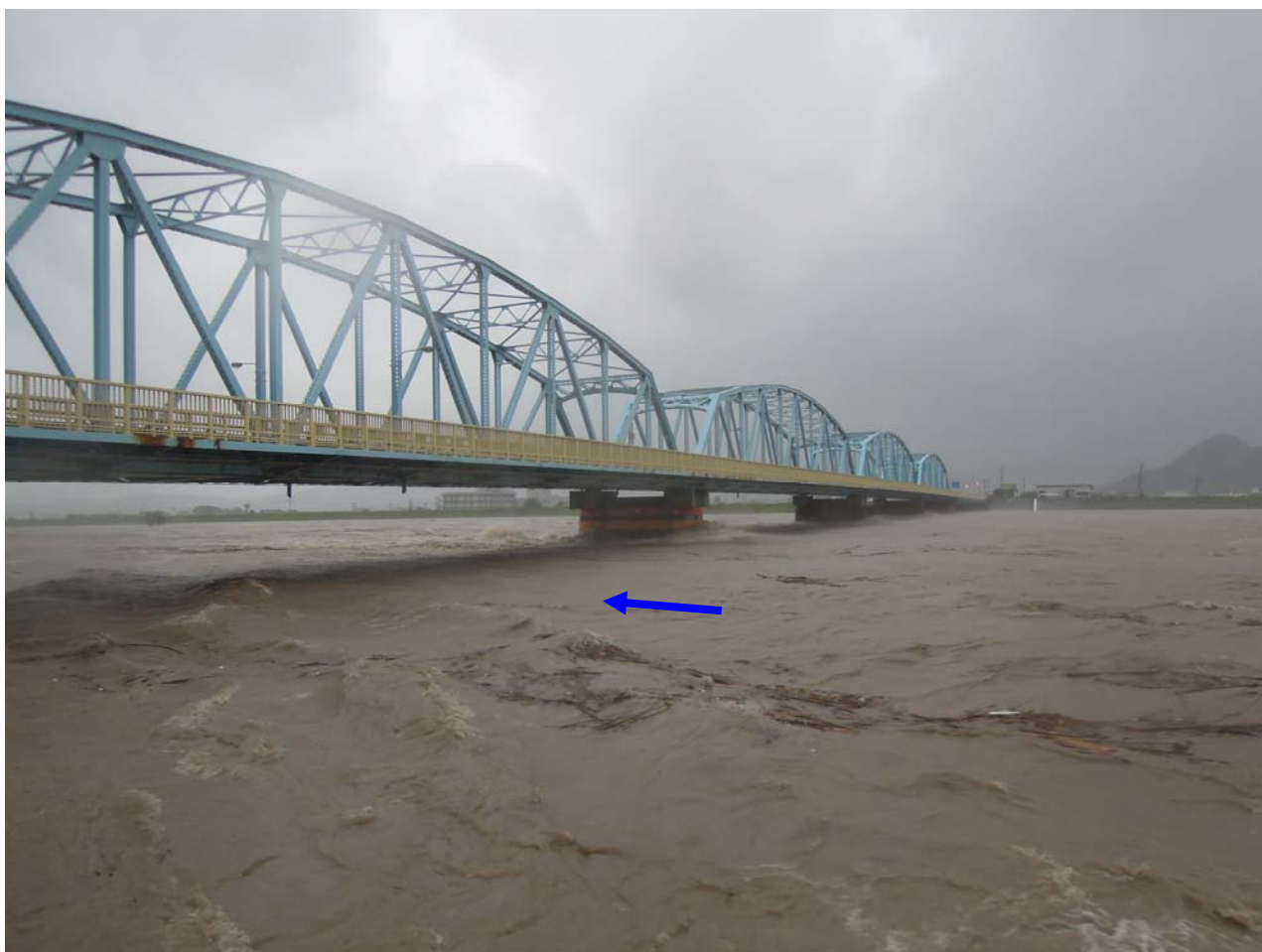
▲ 那賀川橋（那賀川河口から 7.0 km 付近）（平成 23 年 7 月 19 日 18 時 30 分頃） 最高水位（瞬時値：6.97 m）時の古庄地点
