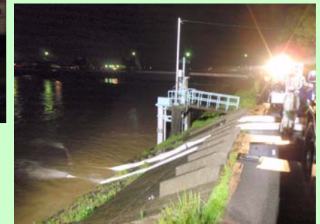
▲排水ポンプ車排水状況(桑野川右岸5.4km付近)
