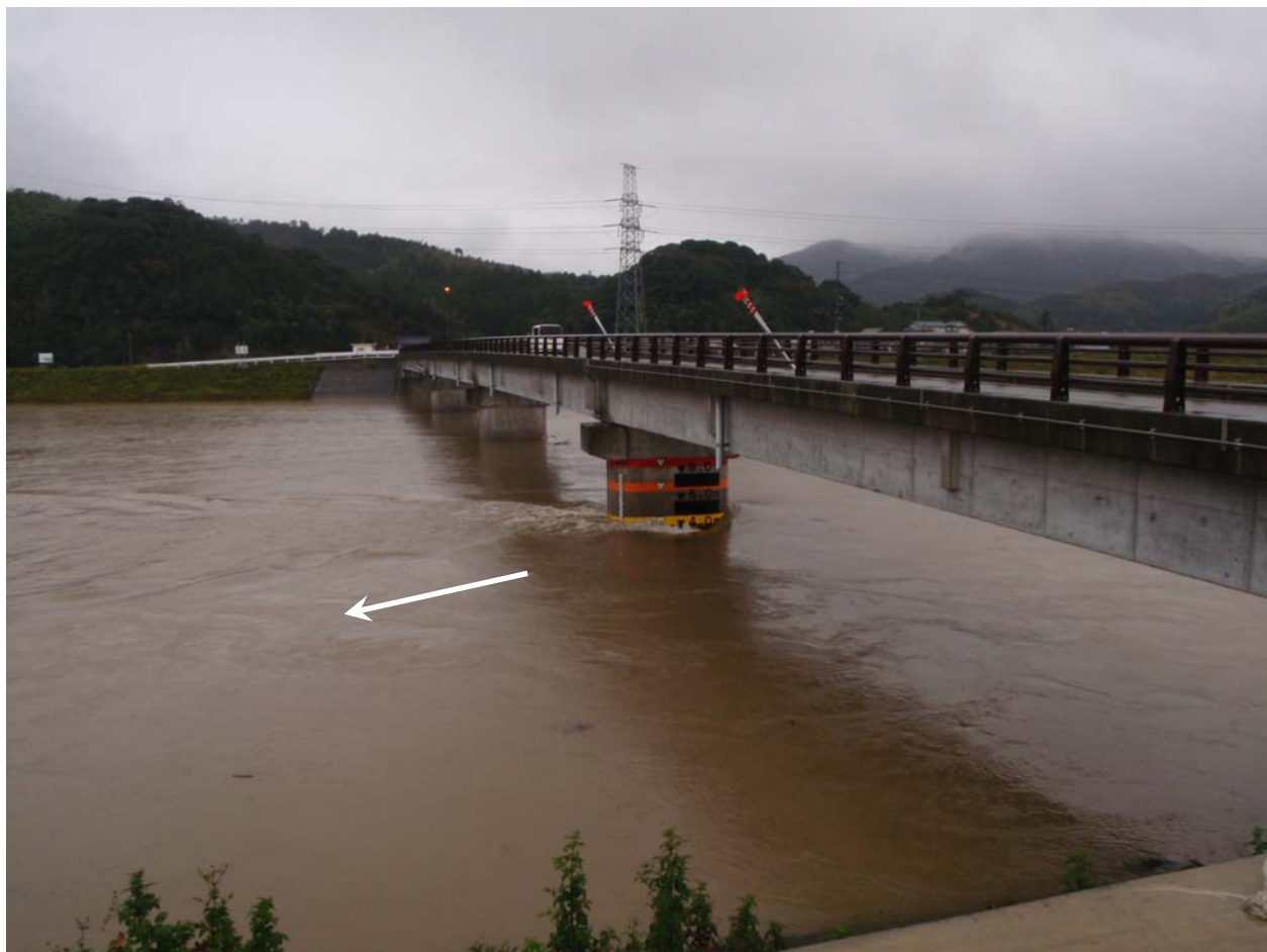
▲長生橋（桑野川9.1 km付近）（平成21年11月11日7時20分頃）
