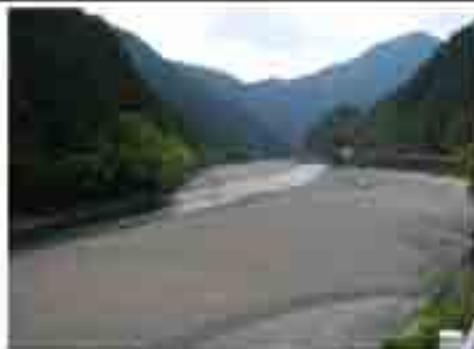
貯水池内堆積状況 (堆砂除去予定箇所)
