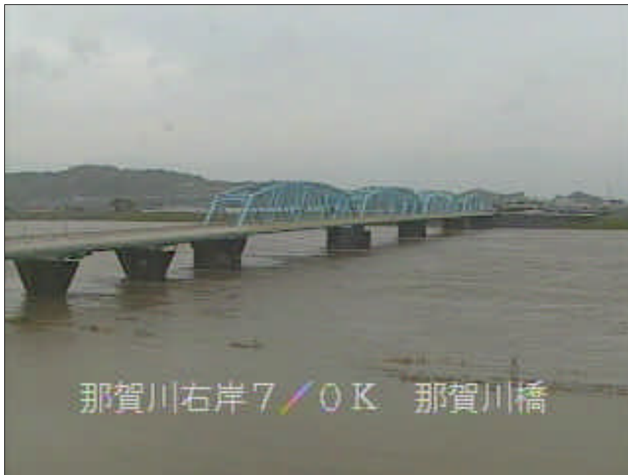
那賀川橋（基準地点古庄）の出水状況 （4月11日16時頃の状況）
