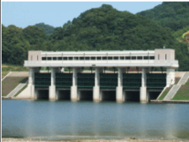
平成17年3月に完成した熊谷川樋門
