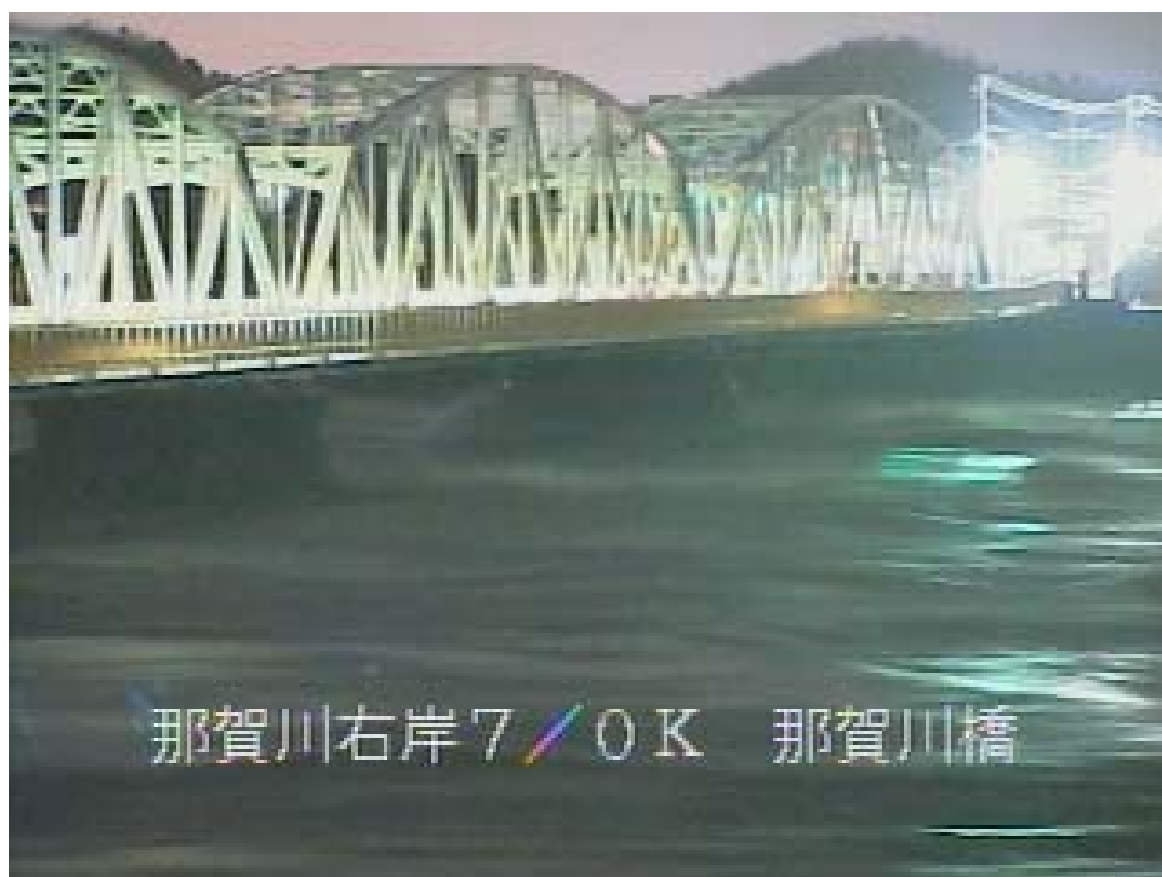
那賀川橋（基準地点古庄）の出水状況 （10月20日19時頃の状況）
