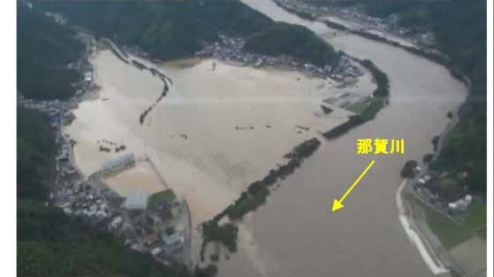
浸水状況写真② 平成26年8月 台風11号
