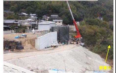
状況写真② 深瀬 16k/2+100付近
