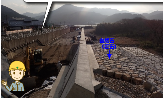
① 自然石(巨石)を利用した多自然護岸や堤防の盛土を施工しました。
