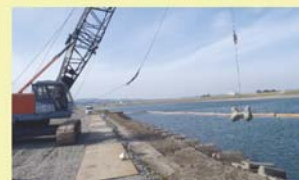
根固ブロック補修状況
