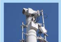
CCTVカメラを設置し、河川内での不法行為の監視を行っています。
