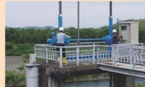
樋門点検状況
