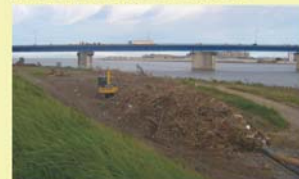
漂着物の撤去状況
