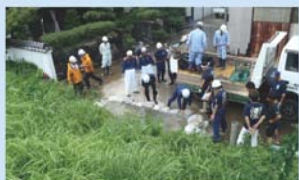
漏水箇所の水防活動
