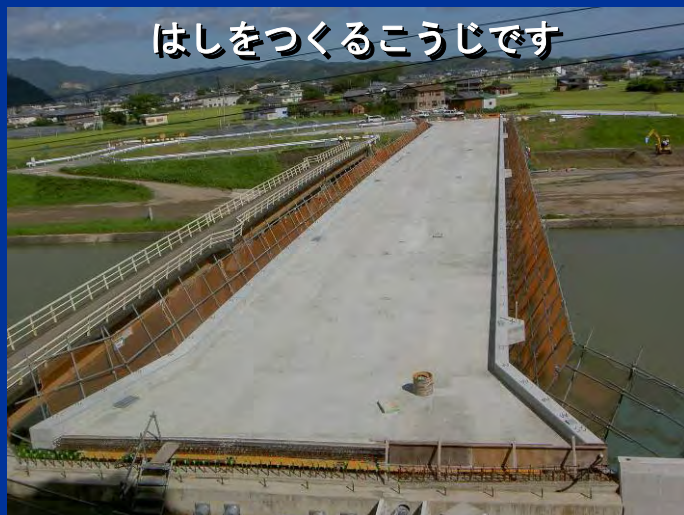
きょうりょうこうじ 橋梁工事
