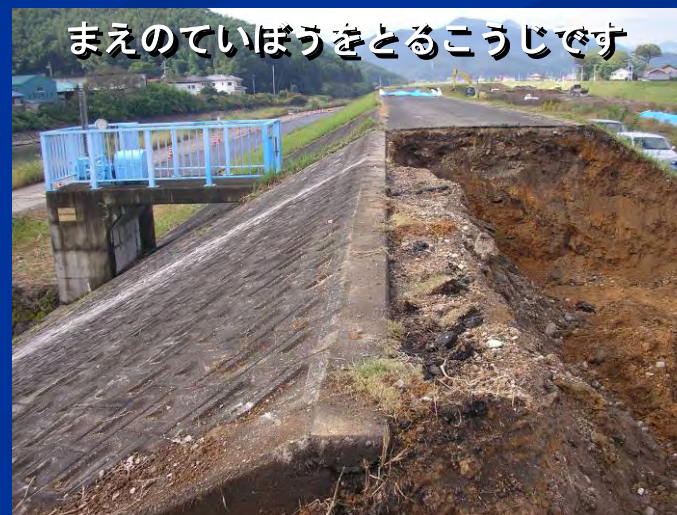
きゅうていてつきょこうじ 旧堤撤去工事
