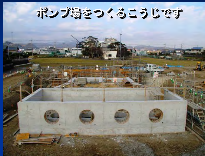
はいすい きじょうこうじ 排水機場工事
