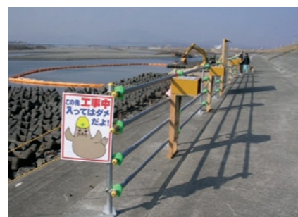
■転落防止柵の設置
