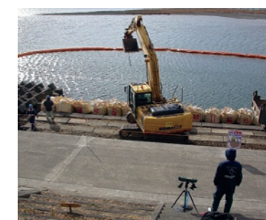
■災害復旧工事中のナカちゃん監視状況
