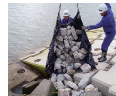
■ナカちゃんをはさまれた隙間への栗石投入状況
