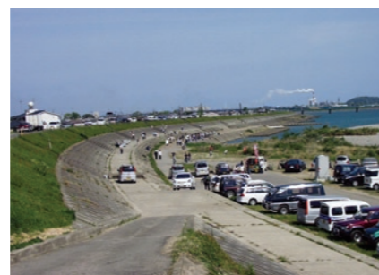
■高水敷に設置された臨時駐車場
