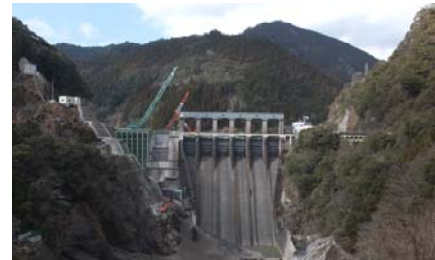
改造事業中の長安ロダム
