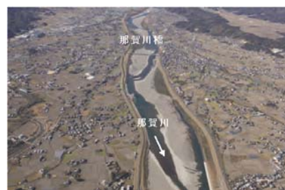
那賀川橋付近(那賀川下流部)
