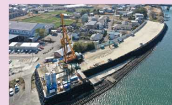
液状化対策の実施状況写真
