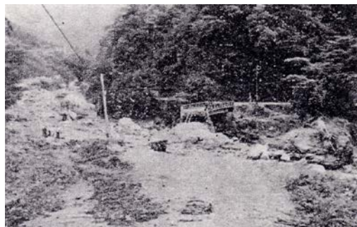
楳谷口県道の欠壊（昭和 49 年 7 月）
