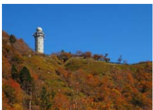
高城山雨量レーダー
