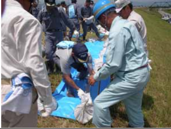
【改良積み土のう工 作業状況】
