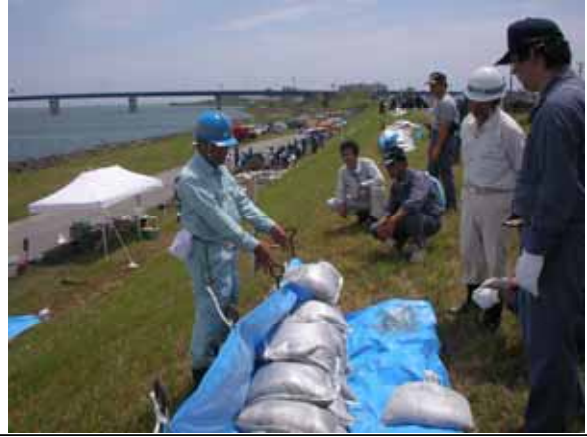
【改良積み土のう工 作業状況】
