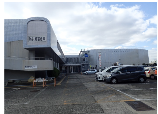
【小松島市総合福祉センター外観】
