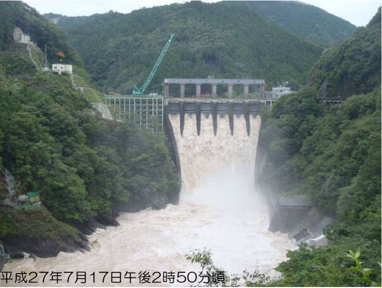
▲長安ロダムの放流状況
