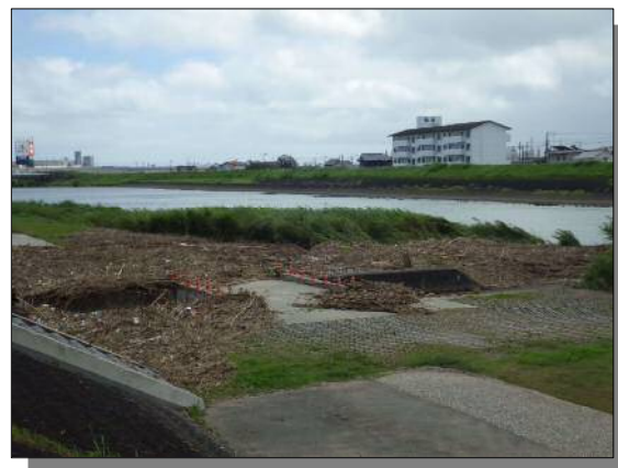
▲前田樋門箇所（桑野川左岸3k600付近）
