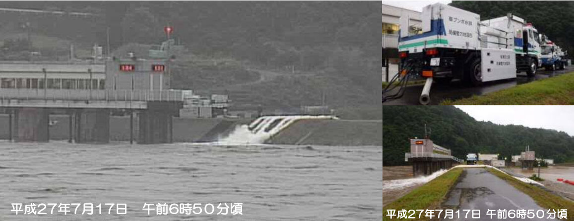
▲吉井地区排水ポンプ車稼働状況
