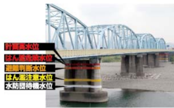
橋脚に表示した例（那賀川橋）
