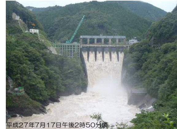
▲長安ロダムの放流状況
