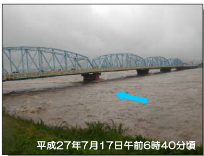
▲那賀川橋直上流・古庄地区（那賀川左岸7k100付近）
