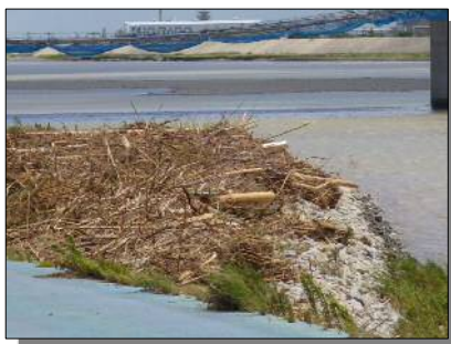
▲那賀川大橋上流・那賀川ふれあい広場（那賀川左岸2k100付近）
