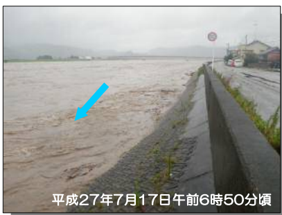
▲那賀川橋上流・岩脇地区（那賀川左岸7k600付近）
