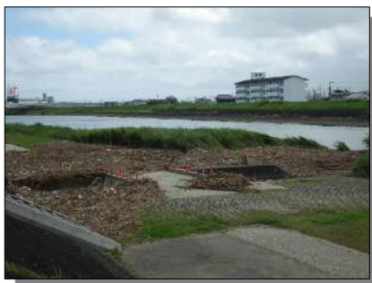
▲前田樋門箇所（桑野川左岸3k600付近）
