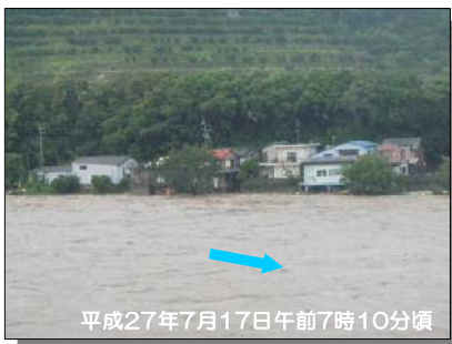
▲持井橋上流・持井地区（那賀川左岸11k400付近）
