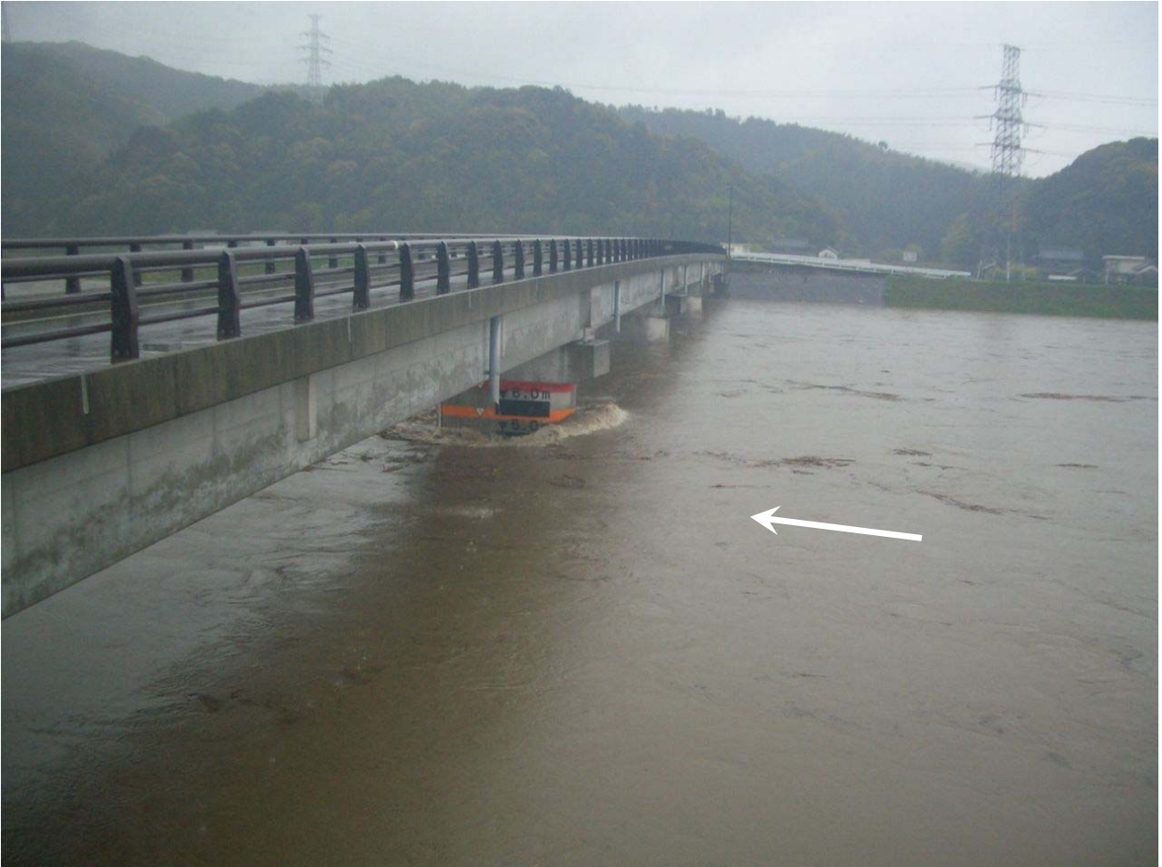
▲長生橋（桑野川 9.1 km 付近）（平成 22 年 4 月 27 日 17 時 40 分頃）
