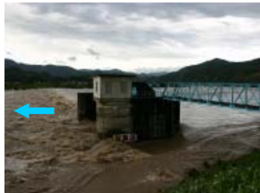
北岸堰（10.4km付近） 〔平成17年9月7日午前7時頃〕
