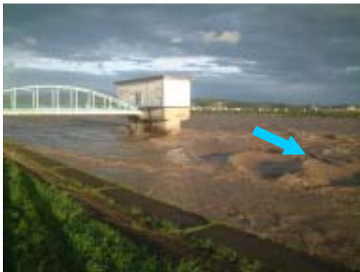
阿南工業用水取水塔（6.0km付近） 〔平成17年9月7日午前6時30分頃〕
