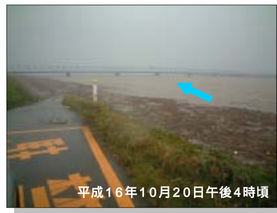
大京原橋付近 (那賀川4.6km付近)
