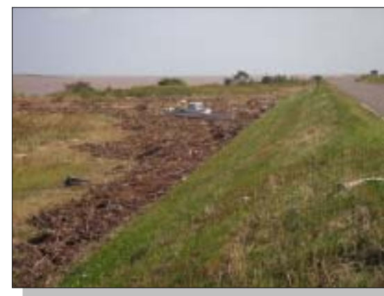
辰巳箇所 (那賀川右岸1.8km付近)
