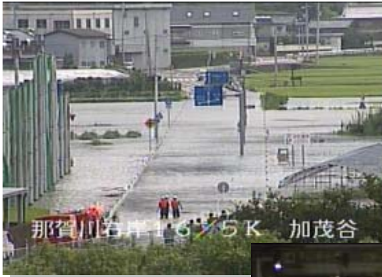
▲ 加茂地区浸水状況 〔平成16年8月1日午前6時頃〕
