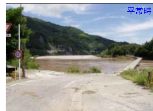
中央橋(潜水橋)
