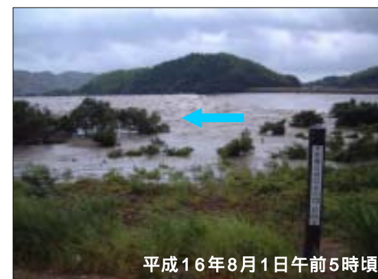
南岸堰の越流状況(13.0km付近)
