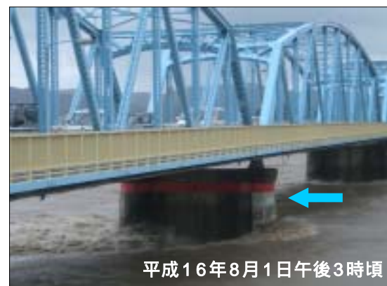
那賀川橋〔基準地点・古庄〕(7.0km付近)
