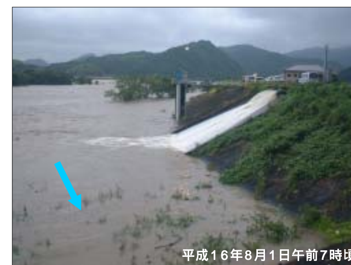
楠根救急排水機場〔排水状況〕(左岸12.5km付近)
