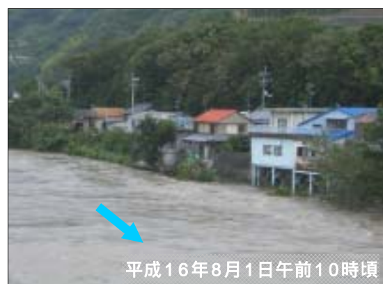
持井橋上流(11.4km付近)
