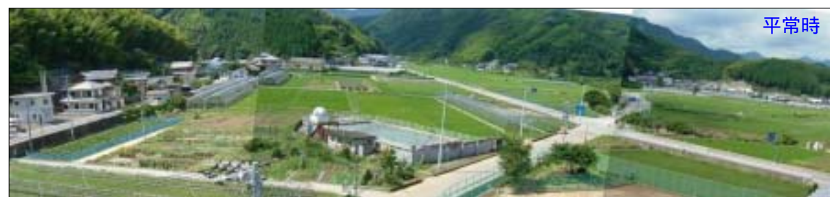
加茂谷中学校屋上から南西を望む
