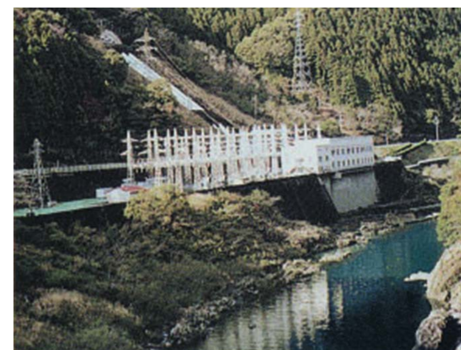
▲日野谷発電所
