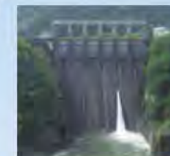
▲長安口ダム低水放流管より 試験放流
