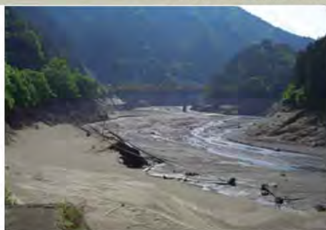
▲長安口ダム上流（出合橋付近H19.5.24）
