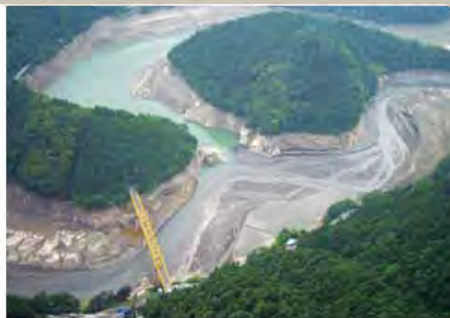
▲長安口ダム上流（出合橋付近H17.6.18）
