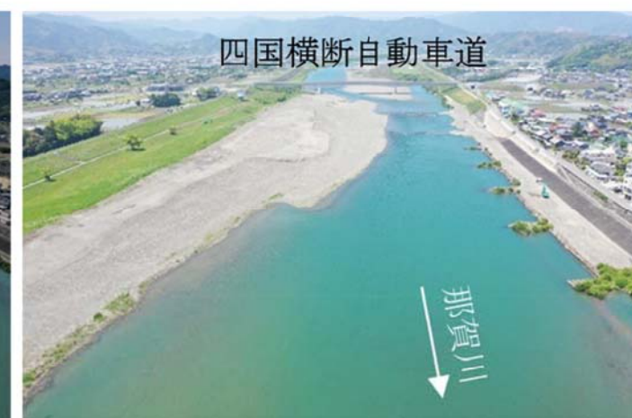
施工後(R3年3月撮影)
