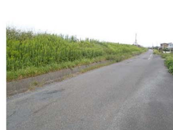
施工前(R2年10月撮影)
