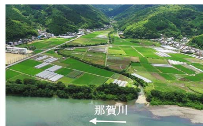
施工前 (H28年6月撮影)
