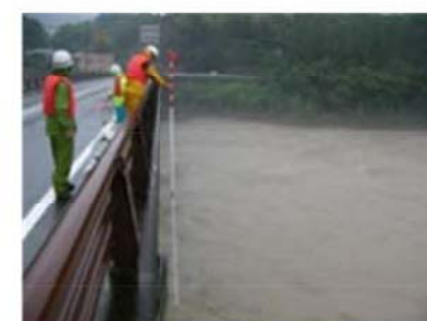
高水流量観測の実施状況
