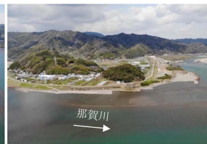
施工後 (R3年3月撮影)
