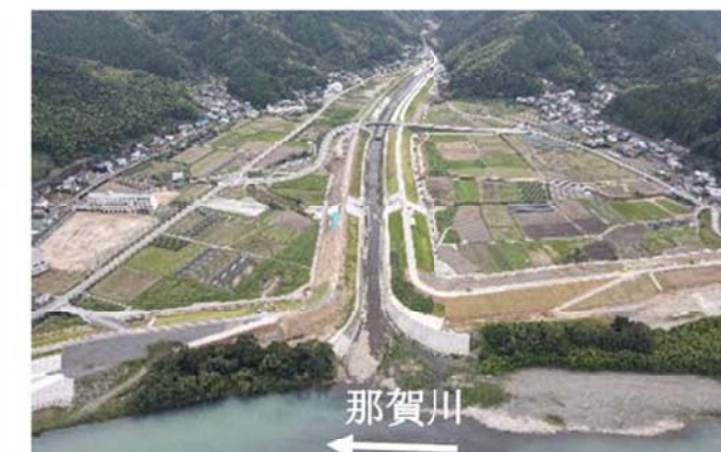
施工中 (R3年9月撮影)
