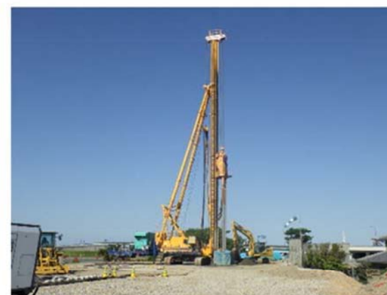
液状化対策実施状況(R2年10月)
