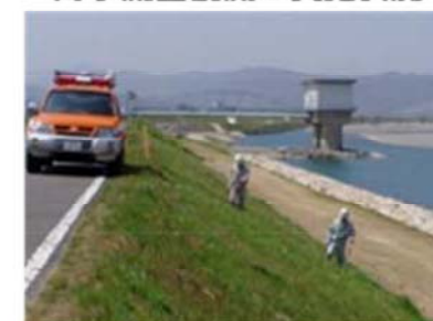
河川巡視・点検の実施状況
