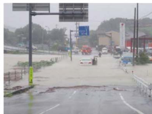
写真① 県道浸水状況 (H26.8台風11号)
