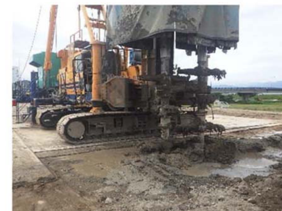
液状化対策実施状況(R2年10月)
