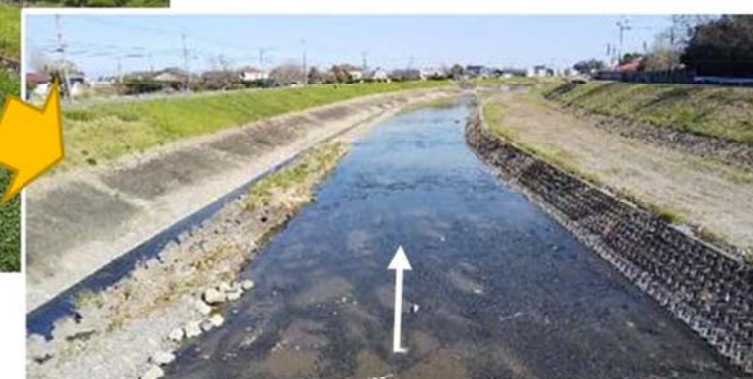
河道掘削状況
