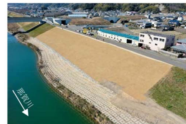
岩脇箇所完成（R2年2月撮影）
