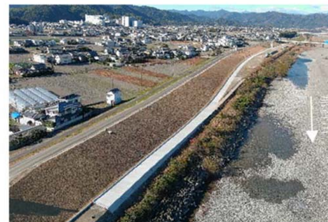
中原箇所完成（R2年1月撮影）
