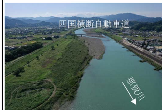
施工前(R2年10月撮影)
