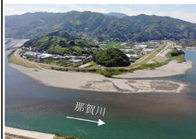
施工前 (R2年6月撮影)
