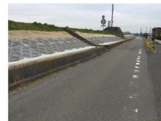
施工後(R3年3月撮影)
